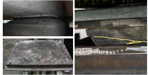
Bild 3: oben links: Elastomerlager – Einbausituation (Quelle: fobatec GmbH), unten links: Anlieferungszustand der Elastomerlager, rechts: beschädigtes Elastomerlager im Schubversuch
