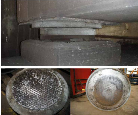
Bild 5: oben: Verformungsleitlager – Einbausituation (Quelle: fobatec GmbH), unten: Verformungsleitlager – Zustand der Gleitebene aus PTFE und austenitischem Stahlblech
