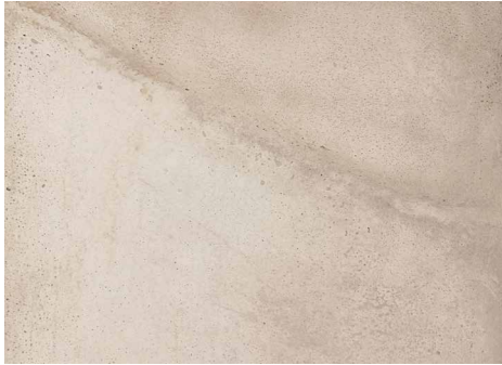
Bild 2: Foto der Betonplatte
