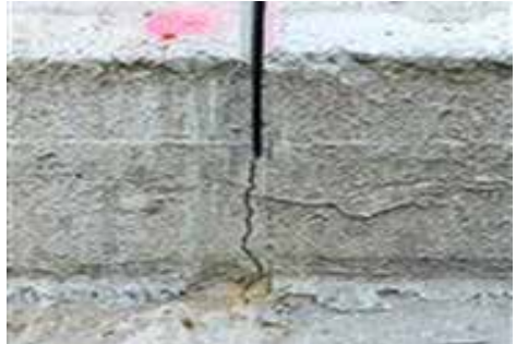
Bild 1: Einschneiden von Längs- und Querfugen (links), Querfuge in junger Betonfahrbahndecke mit Riss (rechts)
