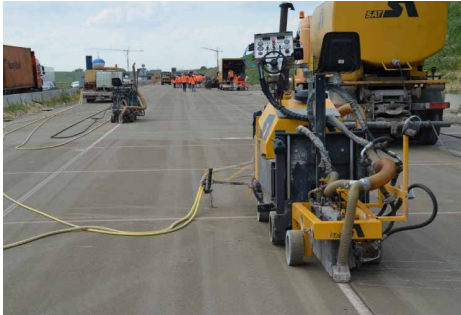
Bild 1: Einschneiden von Längs- und Querfugen (links), Querfuge in junger Betonfahrbahndecke mit Riss (rechts)
