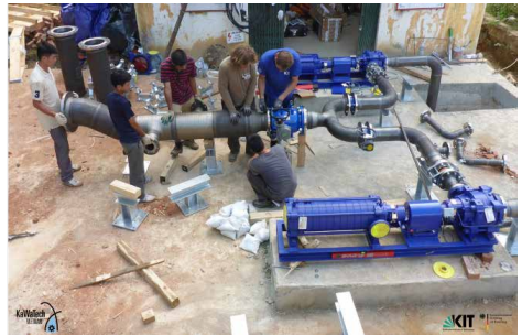
Bild 2: Montage der Wasserförderanlage durch KIT-Mitarbeiter (Quelle: KIT)
